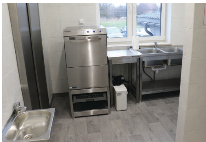
Pomieszczenia nowego żłobka przy ul. Skarbowskiego 10.
