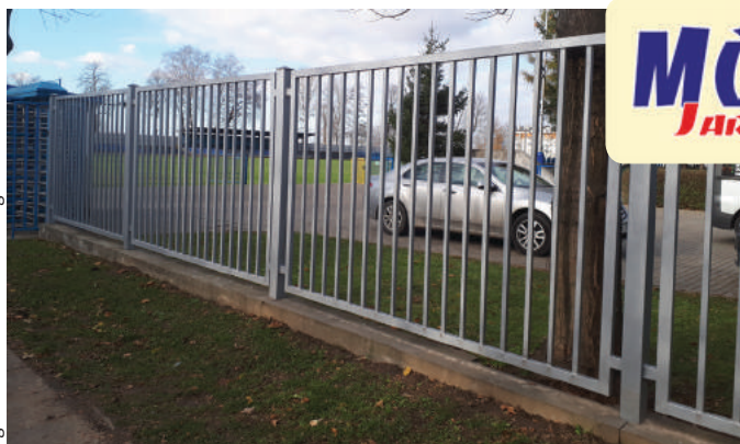
Ogrodzenie od ul. Bandurskiego.
