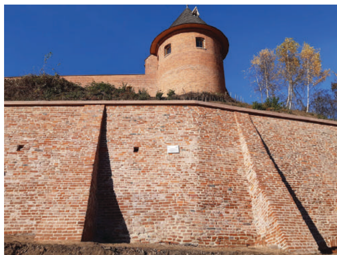
Mur oporowy przy ul. Podgórze.
