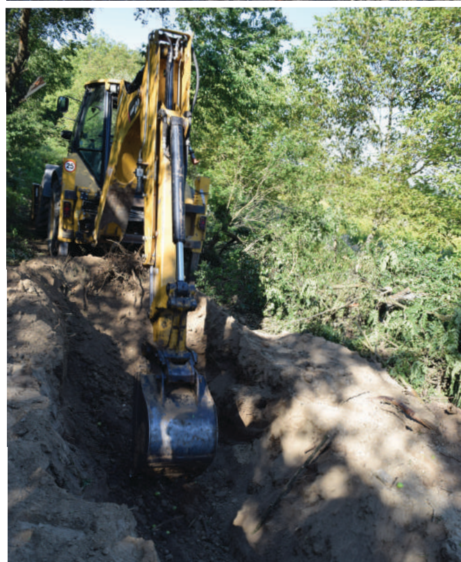
Prace przy budowie kanalizacji sanitarnej.
