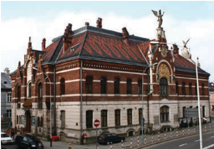
Gmach dawnego Towarzystwa Gimnastycznego Sokół przed remontem, fot. JOKiS.
