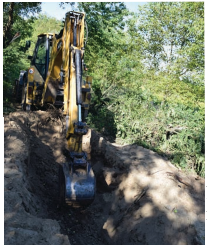
Prace przy budowie kanalizacji sanitarnej.
