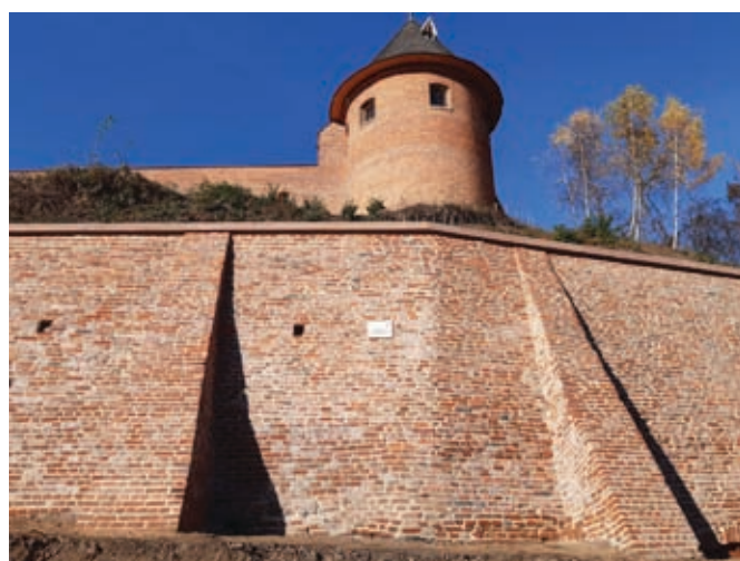
Mur oporowy przy ul. Podgórze.
